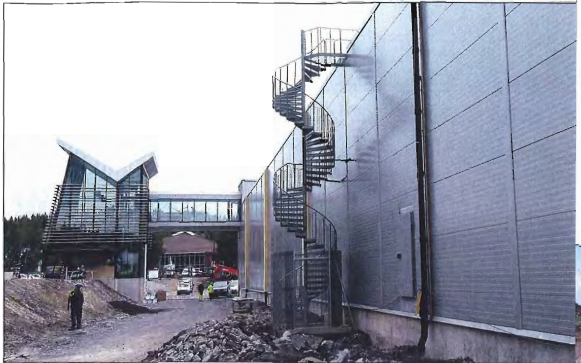
Fasadeveggen med rømningstrapp ned fra taket, der kontorarealene har direkte utgang fra.
